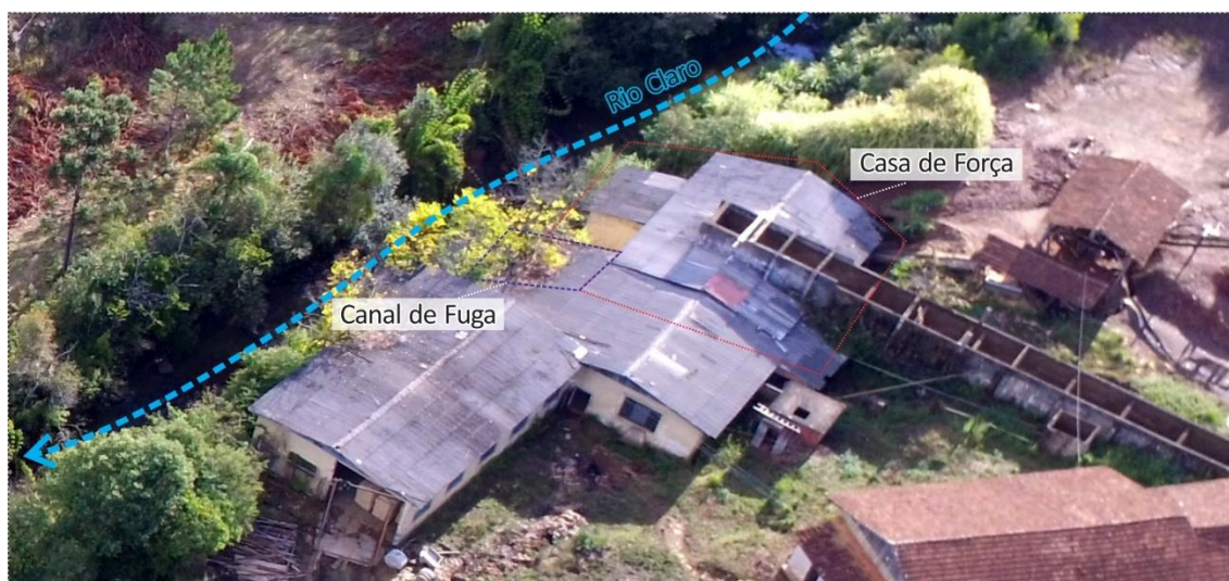
Figura 11 – Casa de Força Imagem: RECITECH, foto de 14.mai.2020.
