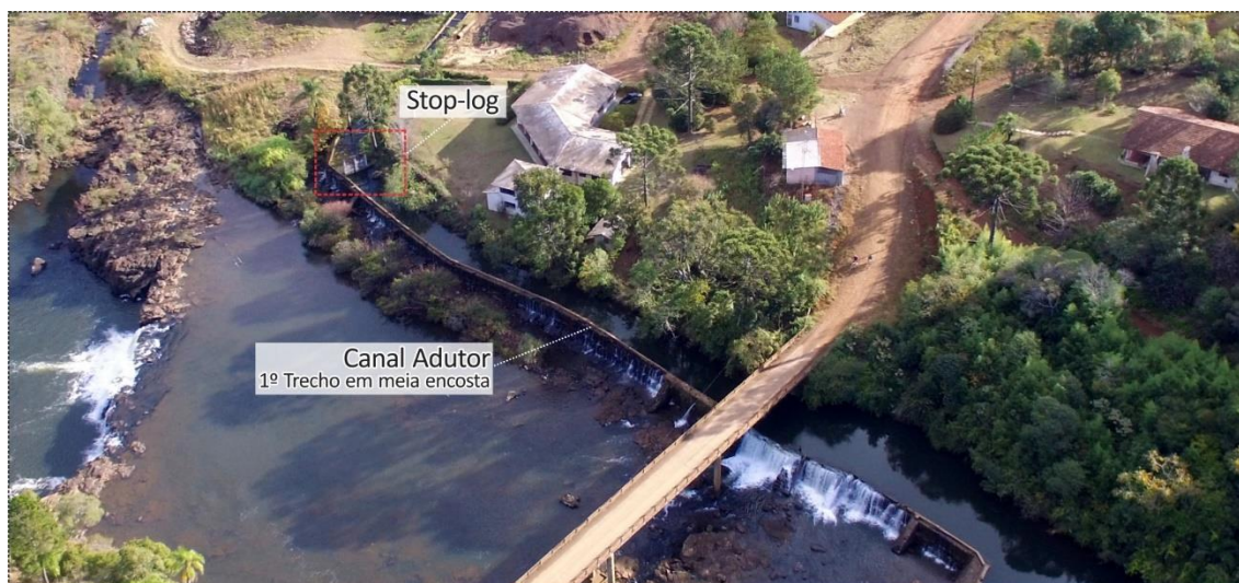
Figura 8 – Canal adutor, primeiro trecho. Imagem: RECITECH, foto de 14.mai.2020.
