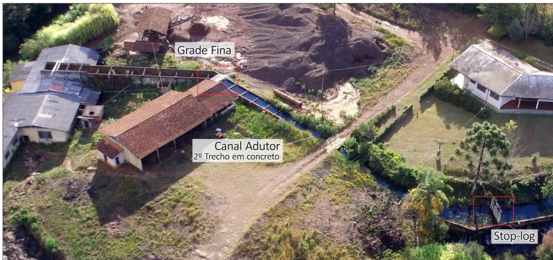
Figura 10 – Canal adutor, segundo trecho. Imagem: RECITECH, foto de 14.mai.2020.
