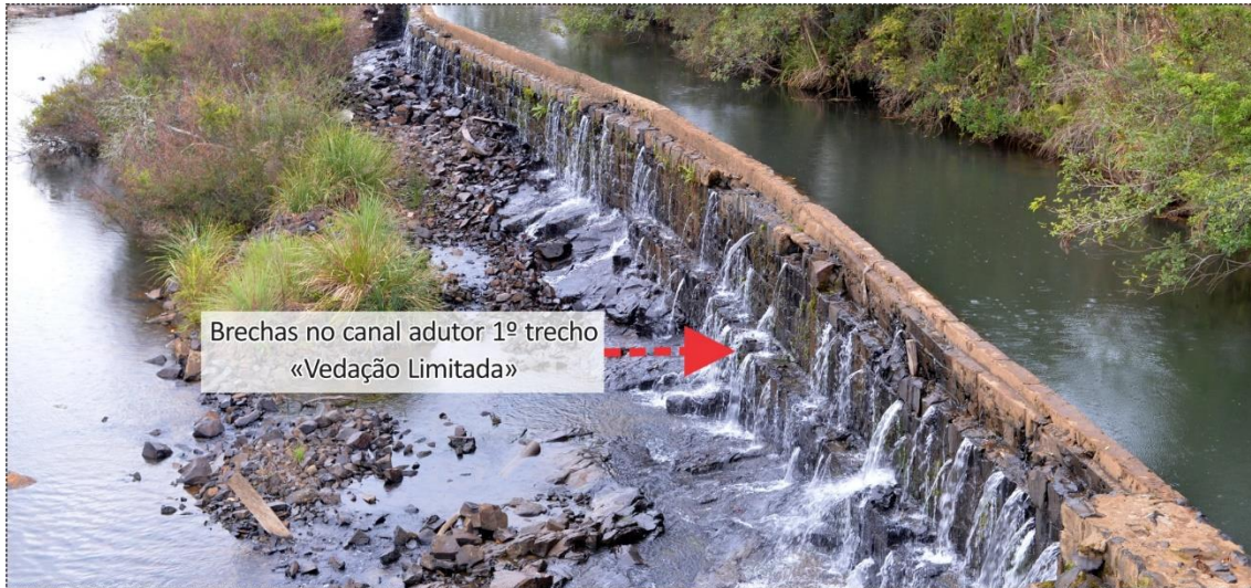
Figura 12 – Vedação limitada no canal adutor Imagem: RECITECH, foto de 14.mai.2020.
